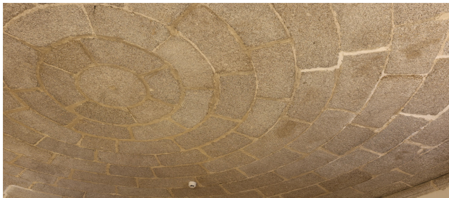
Figura 3.1 Bóveda semi-plana de piedra de la planta baja.
