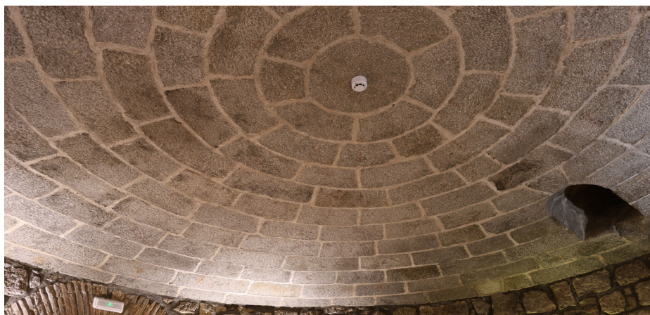
Figura 0.2. Bóveda semi-plana de la planta semisótano del castillo-palacio de Magalia.
