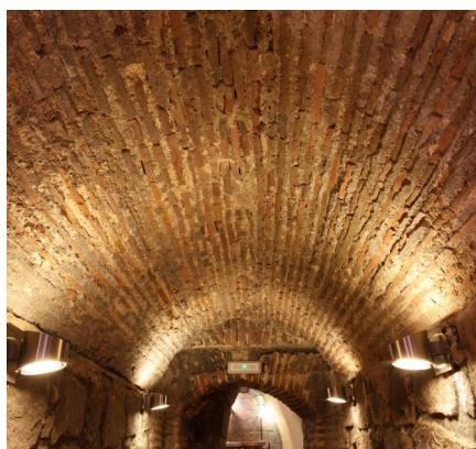
Figura 3.4 Bóveda de cañón de ladrillo de la planta baja.
