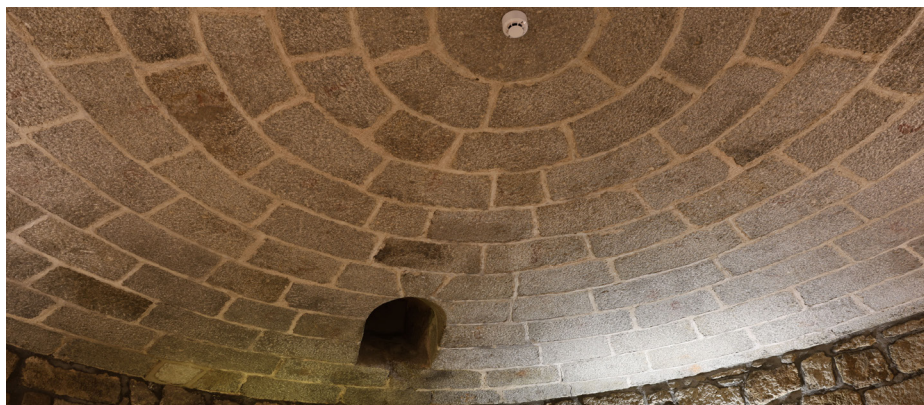
Figura 3.2 Bóveda semi-plana de piedra de la planta semisótano.
