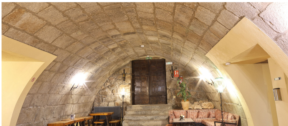
Figura 3.3 Bóveda de cañón de piedra de la planta semisótano.
