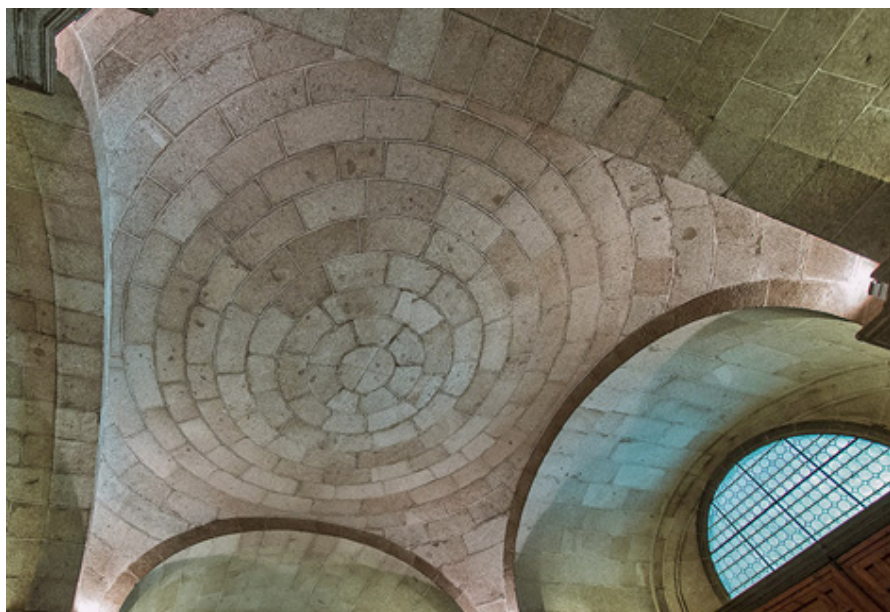
Figura 2.8 Bóveda plana del Monasterio de El Escorial apoyada sobre pechinas.
