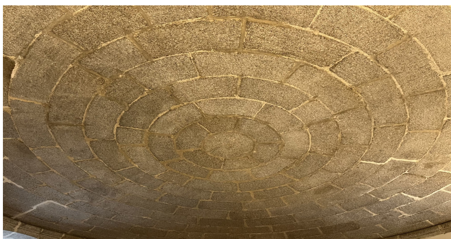
Figura 0.3. Bóveda semi-plana de la planta baja del castillo-palacio de Magalia.
