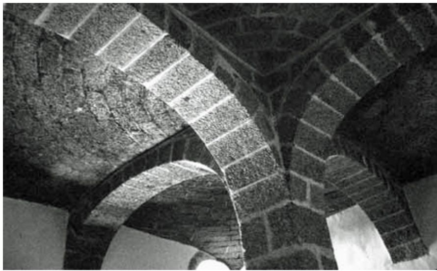
Figura 2.7 Bóveda plana del Monasterio de El Escorial de planta cuadrada.
