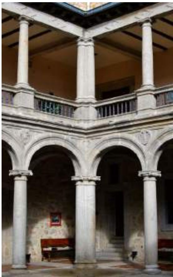
Fig. 52: Solución de esquina del patio del castillo-palacio Magalia. Foto: Manuel Parada.
